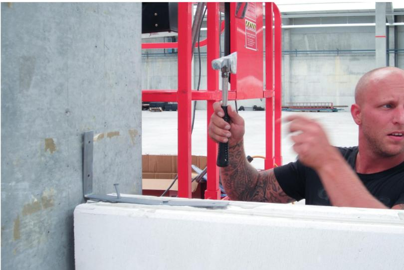
Vinculación con estructura de Hormigón
