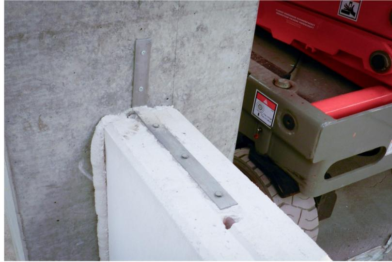
Vinculación con estructura de Hormigón
