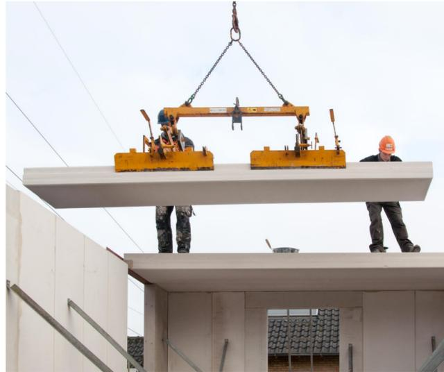
Paneles de losa autoportante de hasta 6m de longitud. Sin capa de compresión
