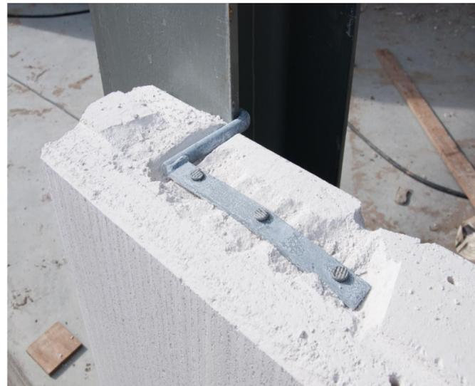
Vinculación con estructura Metálica
